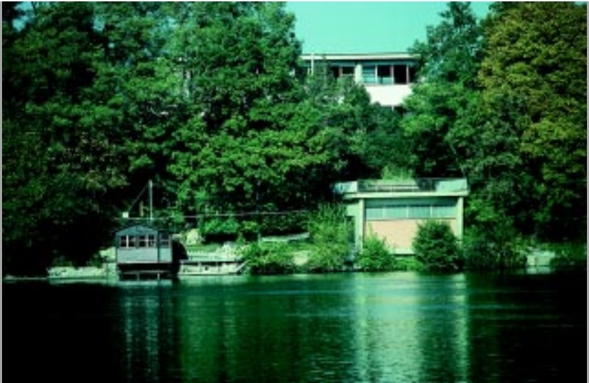
Abbildung 3: Rohwasserentnahme Rhein Km 163,9 oberhalb des Kraftwerks Birsfelden
